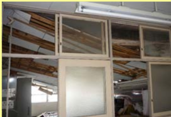
●地震により天井が崩落した教室
