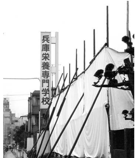
復旧が進められる校舎。
