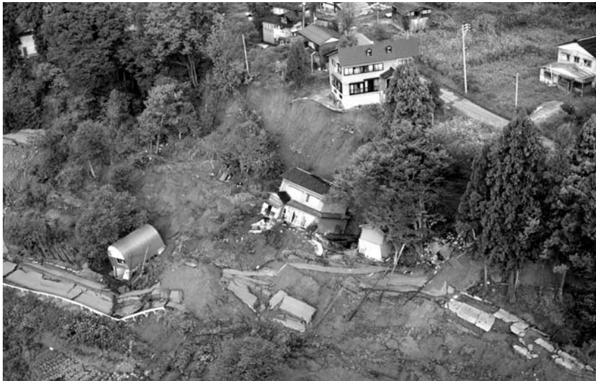
2004〔平成16〕年10月23日、土砂崩れて滑り落ちた家屋。新潟県中越地震。
